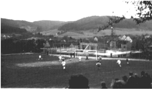
1. Mannschaft vor Hallenbaustelle 1963
